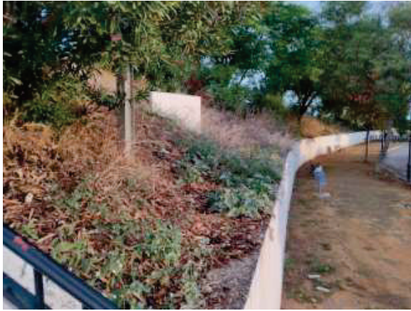
Obra en C/Magnolio
