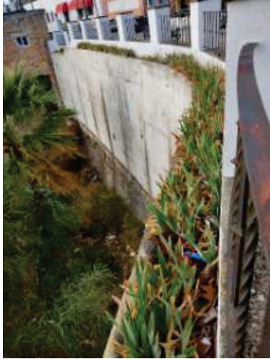
Entrada venta Pinar (obra)
